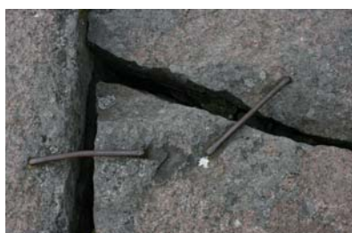
En detalj från utlastningskajen.
